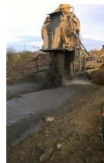
Réalisation d'une tranchée de mélange sol-ciment au moyen d'une trancheuse spécialement conçue pour :
