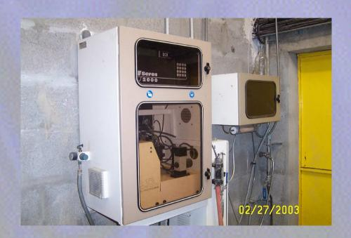
Les eaux rejetées sont analysées par divers équipements: Débit,PH,DCO,turbidité,échantillonnage automatique.
