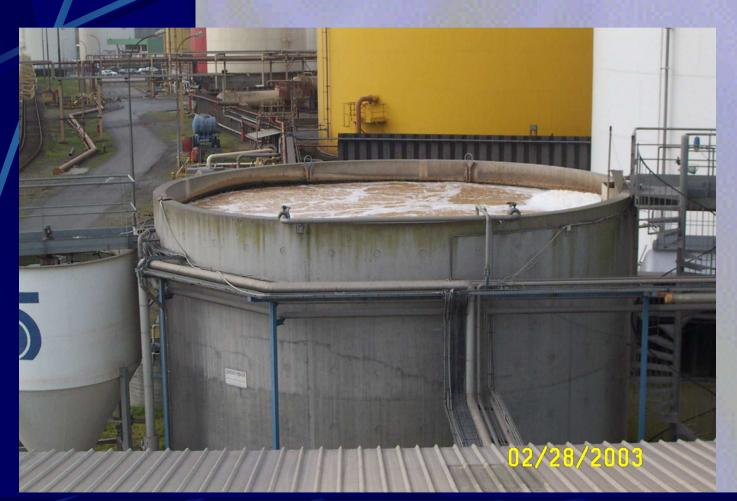
Le traitement dans le bassin d'aération est de type biologique avec une injection continue d'air et de nutriments.
